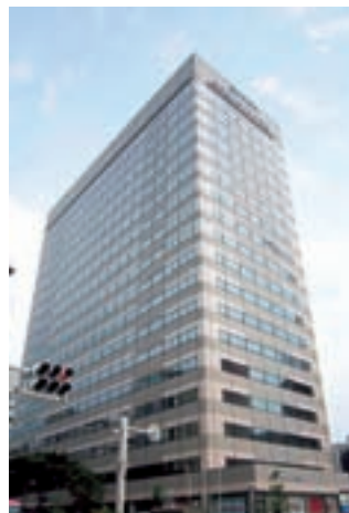
名古屋三井ビル本館外観
