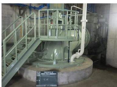
ポンプ場整備事業
