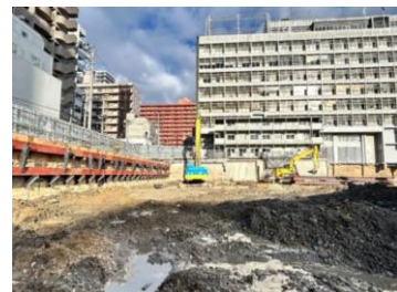
▼新本庁舎地下部分掘削状況
